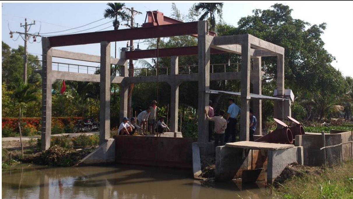
Hình 131: Hình ảnh thực tế trạm bơm điện tưới tiêu kết hợp xây dựng ở ĐBSCL
